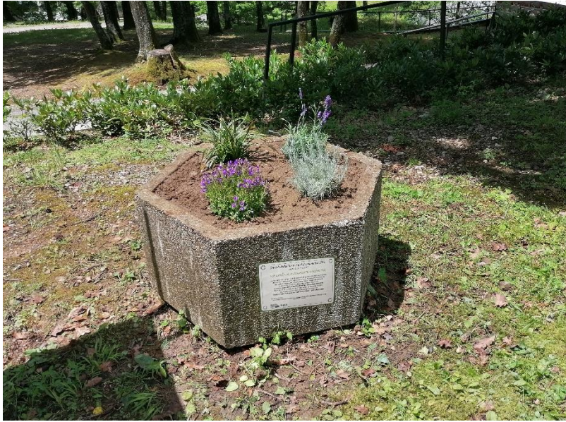
Slika 3: korito po izvedbi
