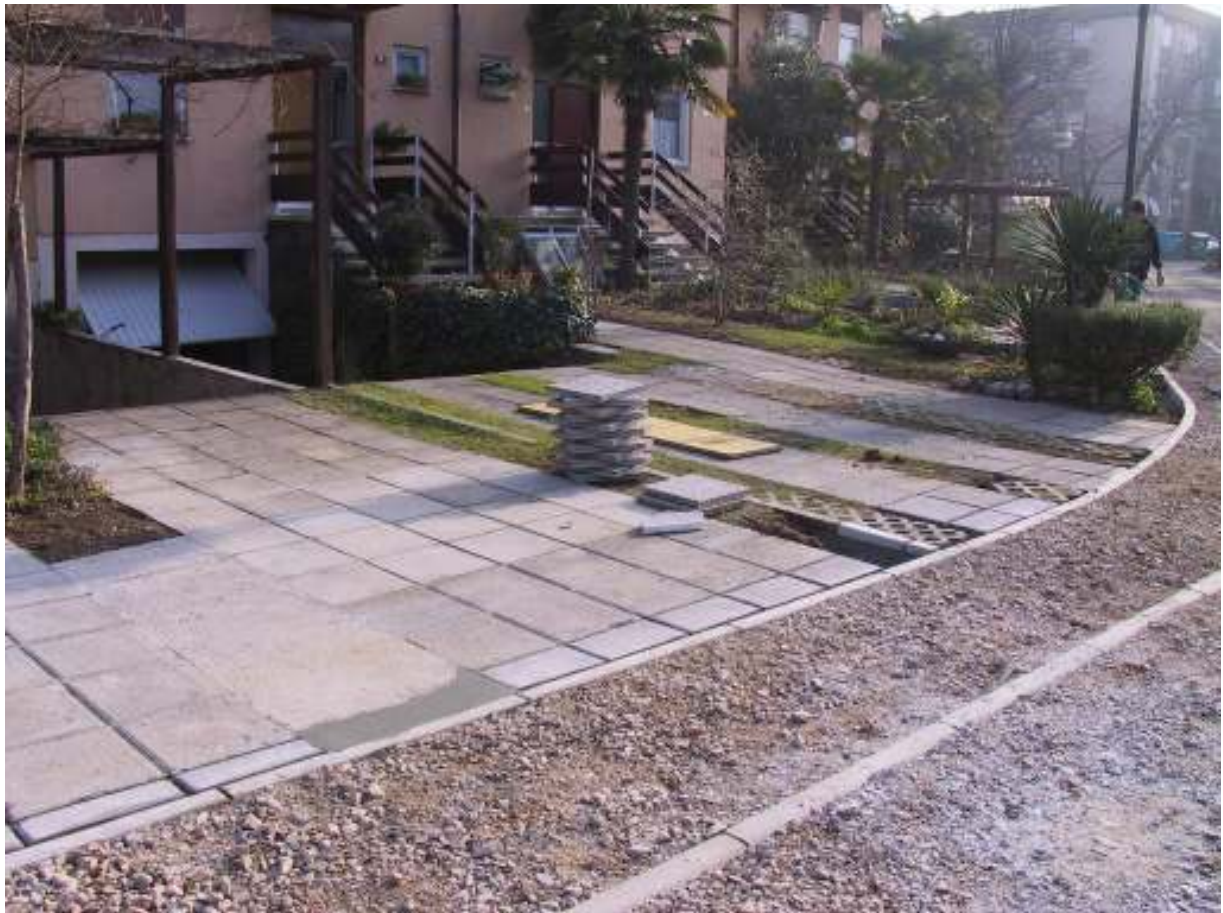
Slika 5: obnova vodovoda (pločnika in ceste) v ulici Ivana Regenta
