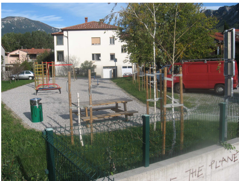
Ureditev otroškega igrišča v Ajdovščini - delo enote vzdrževanje površin
